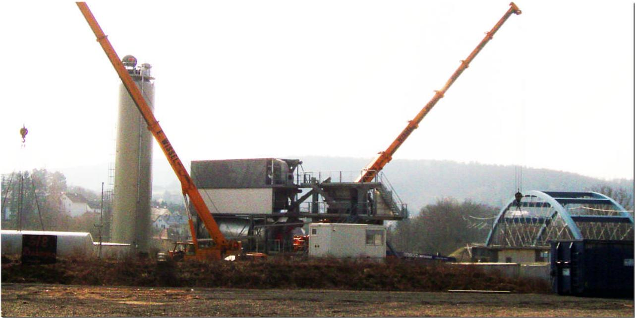
Das Asphaltwerk der Firma Kirchner in den Weiberhöfen ist, wie geplant, wieder demontiert. Hier ein letztes Bild vom Abbau.
